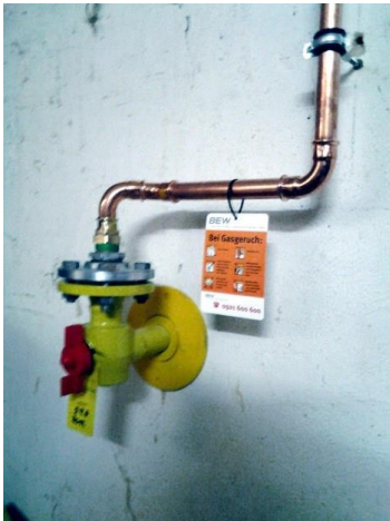
Axialausgleich mit Cu-Rohr
