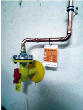
Axialausgleich mit Cu-Rohr
