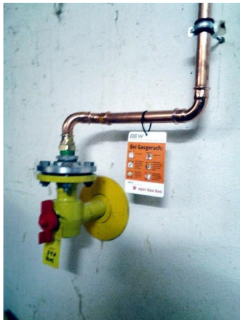
Axialausgleich mit Cu-Rohr
