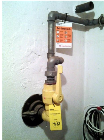
Axialausgleich mit Stahlrohr jedoch ohne Strömungswächter
