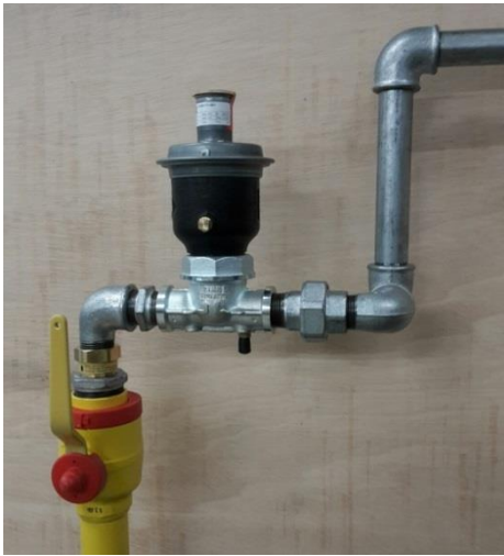
Hausanschluss, eND geschraubt
