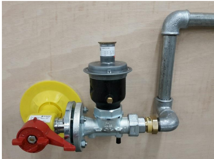
Hausanschluss, eND geflanscht
